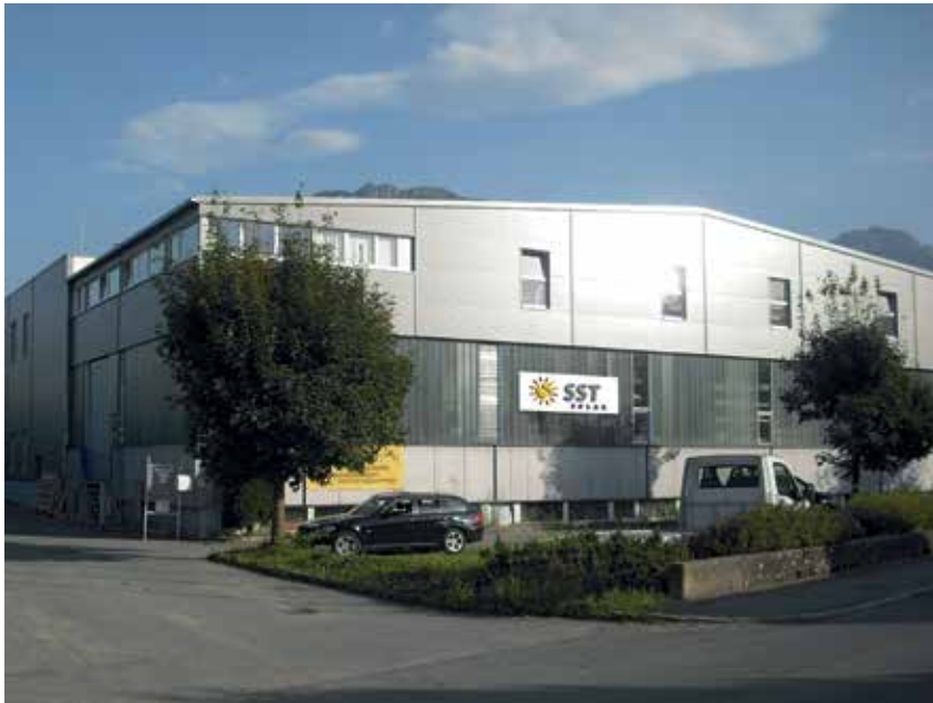
Produktionshalle in Schlins, Österreich.
