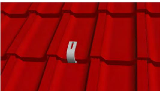
Fertig eingedeckter Ziegelhaken nach dem Eindecken.
